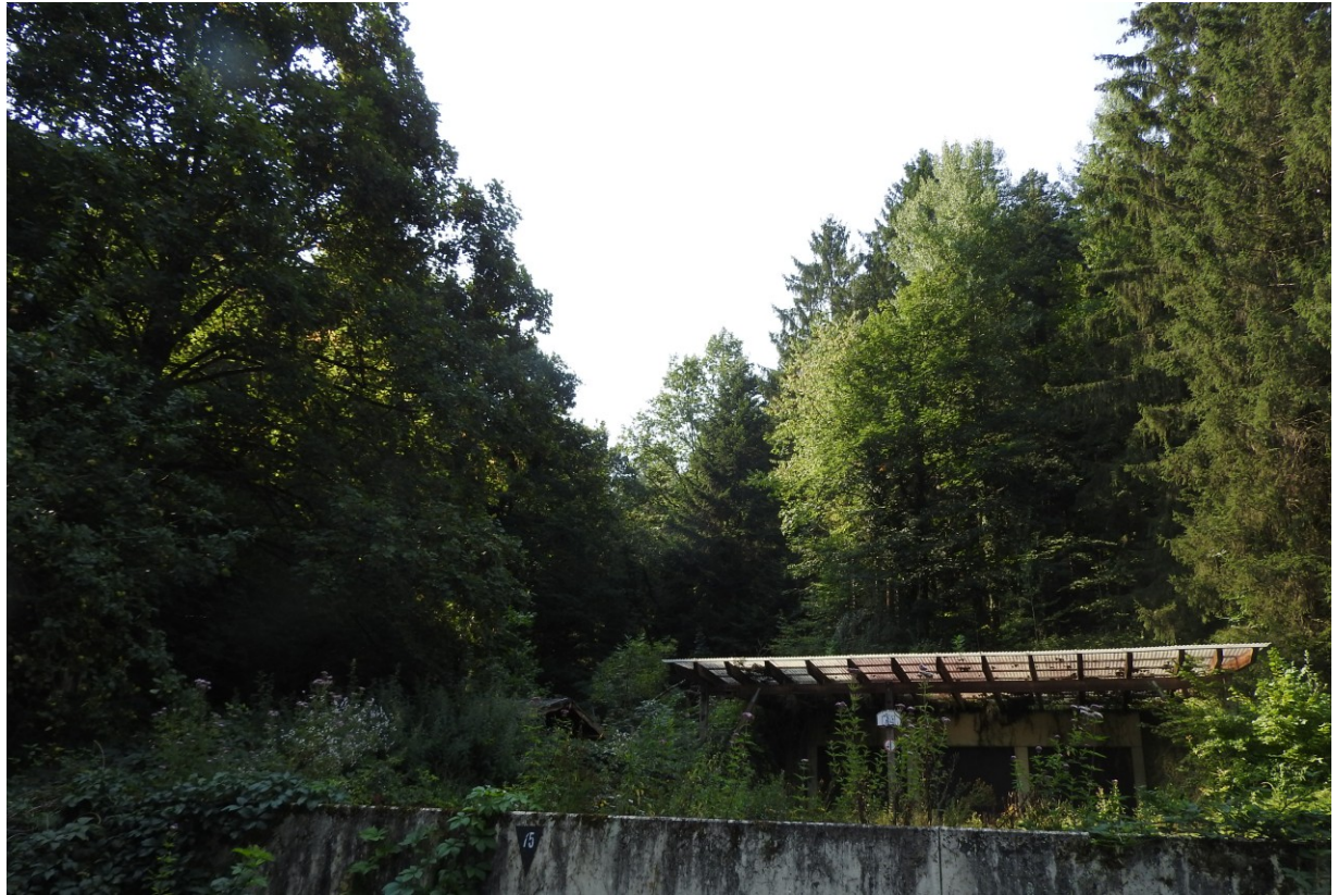
Abbildung 7: Fläche 3 Ostseite oberhalb der Hoffläche
