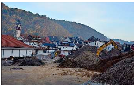
Im ganzen ZTL wurden im Zuge des Ausbaus der Elztalbahn sogenannte „Bauhöfe“ zur Lagerung von Schotter, Erdaushub und Maschinen angelegt. Fotos: Detlef Berger
