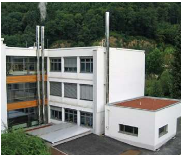
Abbildung 21: Heizzentrale des Wärmenetzes Gymnasium
